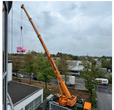
Aufwendige Anlieferung: Das neue MRT-Gerät (rosa verpackt) kommt per Kran in die Praxis. Foto: Radiologie Ottobrunn
