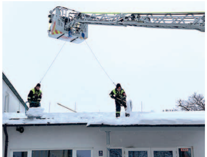
Auf dem Dach der Grundschule an der Friedenstraße konnte teilweise nur mit Absturzsicherung gearbeitet werden.
