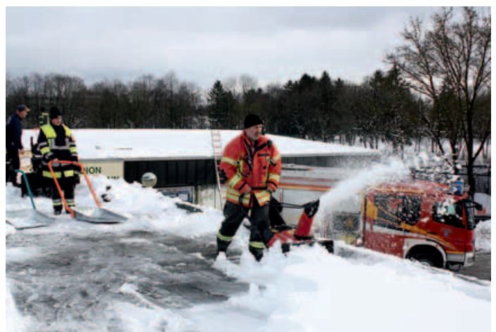
Streifenweise wurden die Schneemassen von den Dächern heruntergenommen; hier auf der Ferdinand-Leiß-Halle mit Schneeschiebern, Schaufeln und Schneefräsen.
