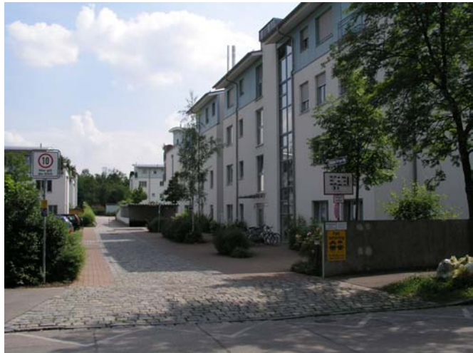
Siedlung mit Blockheizkraftwerk
