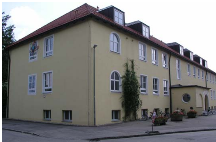
Sanierte Schule in Ottobrunn Foto: Gemeinde Ottobrunn
