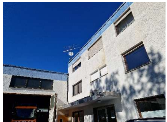
6. Gebäude Jägerweg 8, Prüfung schließt pot. Strukturen am Gebäude aus.
