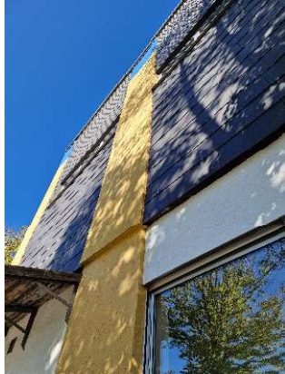
1. Gebäude Haidgraben 1a.
