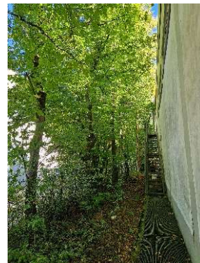
14. Bestand an östlicher Grundstücksgrenze, kaum Unterholz und Nähe zum Gebäude.
