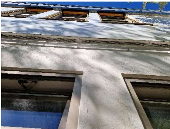
3. Gebäude Haidgraben 1 mit pot. Öffnungen (verschlossen) sowie Überprüfung der Außenjalousien.
