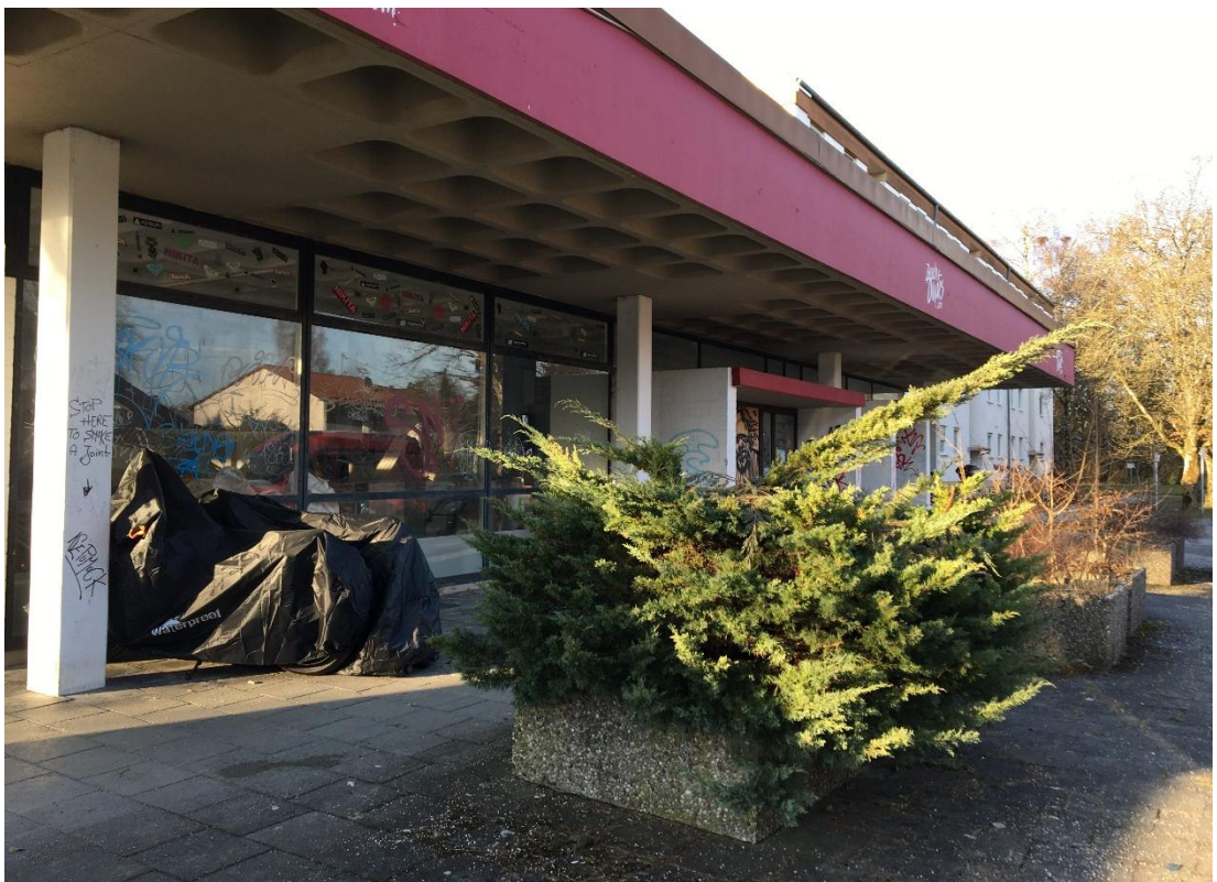
Abb. 7 Aktueller Zustand des ehemals gewerblich genutzten, eingeschossigen Gebäudes im Umgriff des gegenständlichen Bebauungsplans (Zaunkönigstraße 15)
