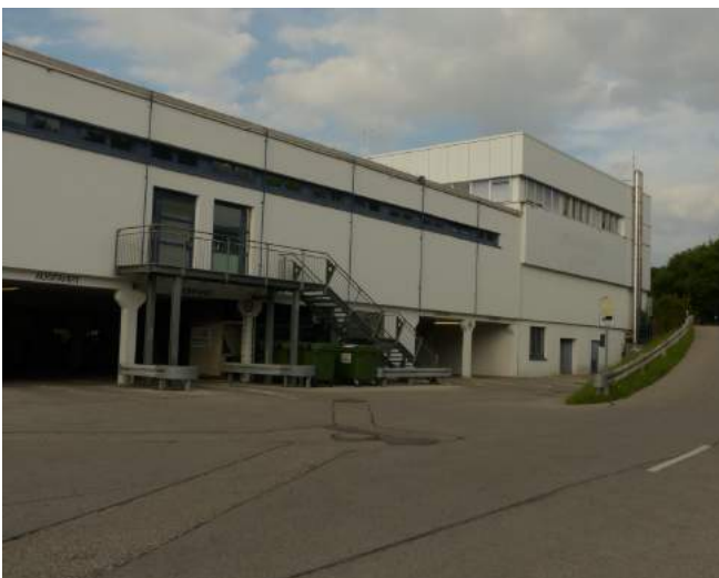
Abb 4: Fassaden des Bestandsgebäudes (Bildquelle DRA)
