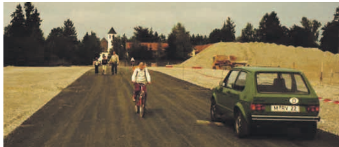
Die Rathausstraße zu Beginn der Bauphase.
